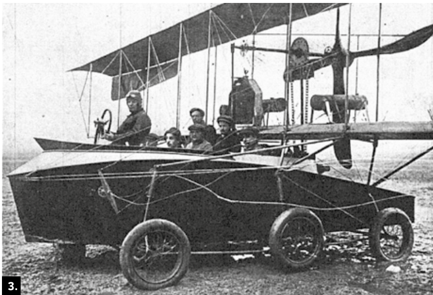
Рис. 3. Амфибия Icare – первая амфибия с полуубирающимся шасси
