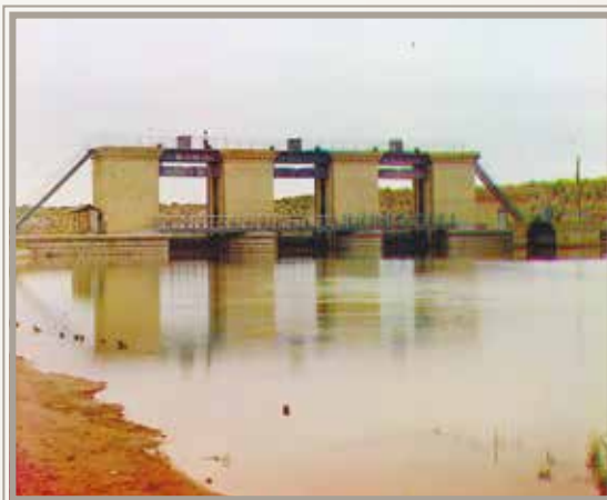
Общий вид Султан-Бентской плотины
