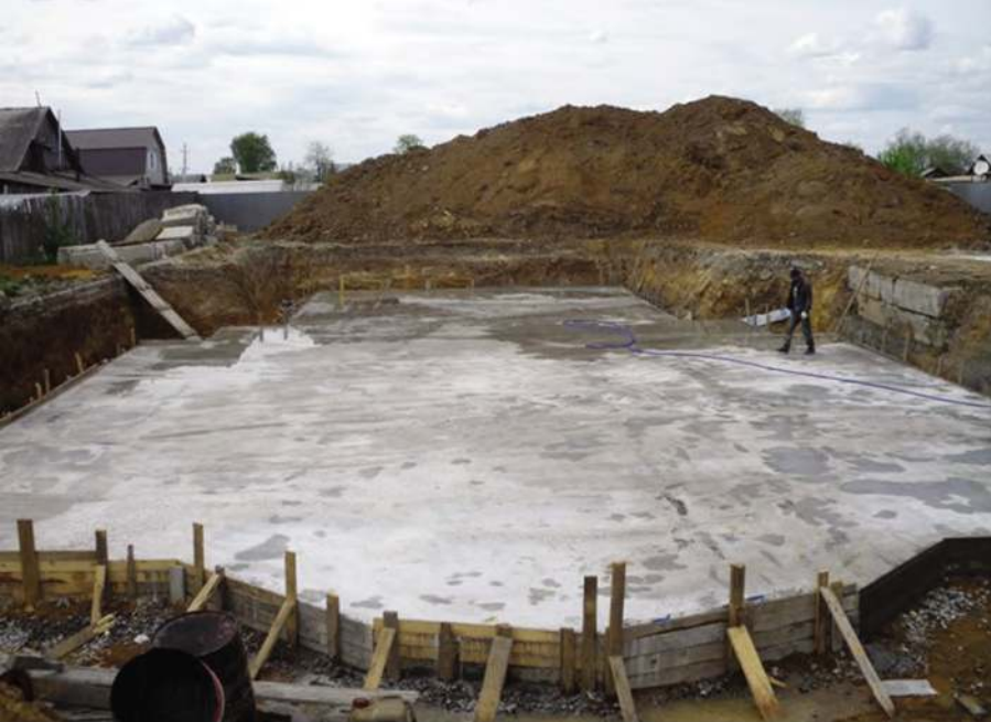
Заливка фундамента храма в Алапаевске. 2015 г.
